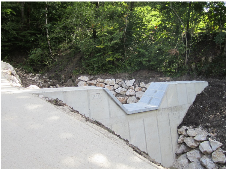
Abb. 1: Geschieberückhalt Reit- bach mit neuer Sperre
